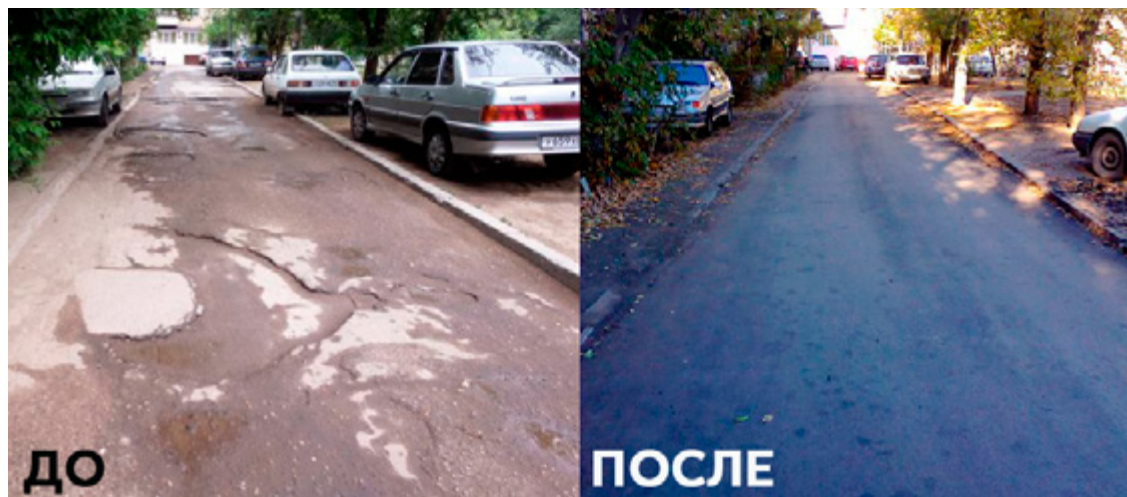
Результат ремонта дороги с помощью проекта РосЯма в г. Волжский
